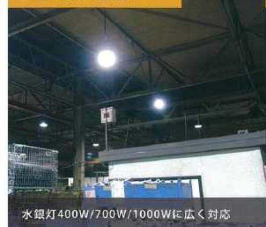
工場・倉庫の高天井
